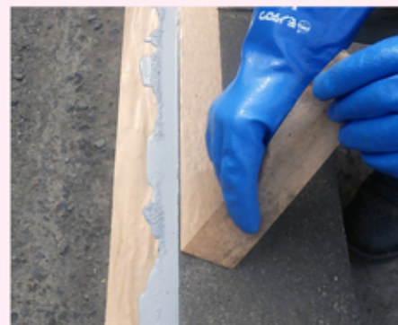
⑥ 養生テープの除去
