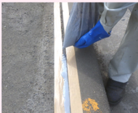
⑤ 目地部への注入
